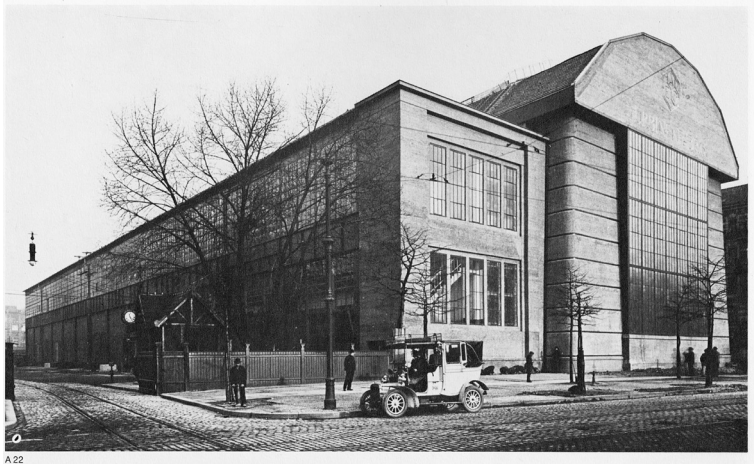
III. 4. Peter Behrens, Turbinenfabrik, Mantagehalle, Berlin 1909 (from Tilmann Buddensieg, Henning Rogge, Industriekultur. Peter Behrens und die AEG 1907–1914 , Gebr. Mann Verlag, Berlin 1981).
